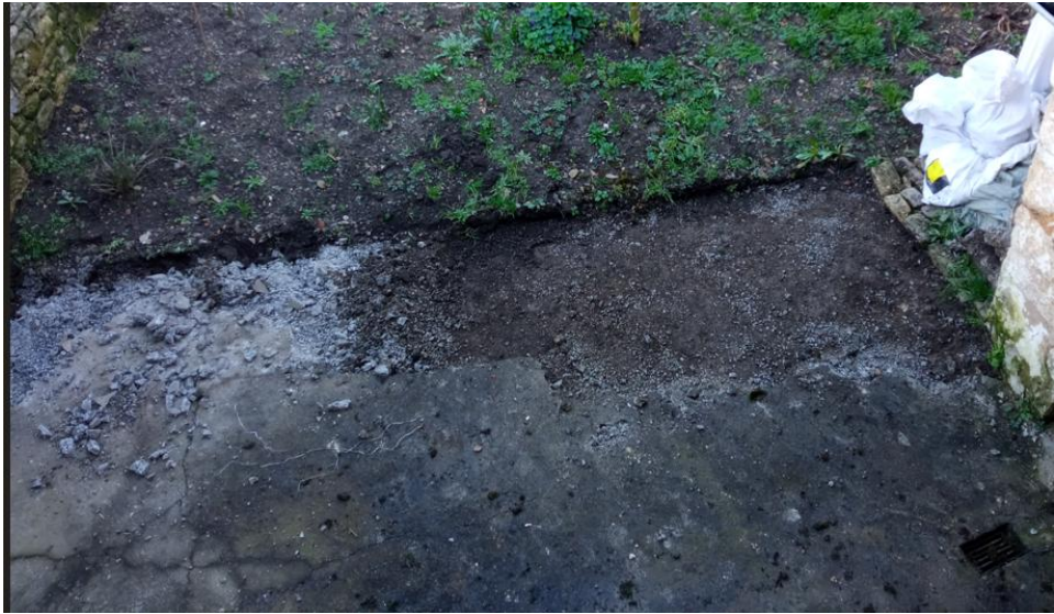
Avant (dalle en béton)
