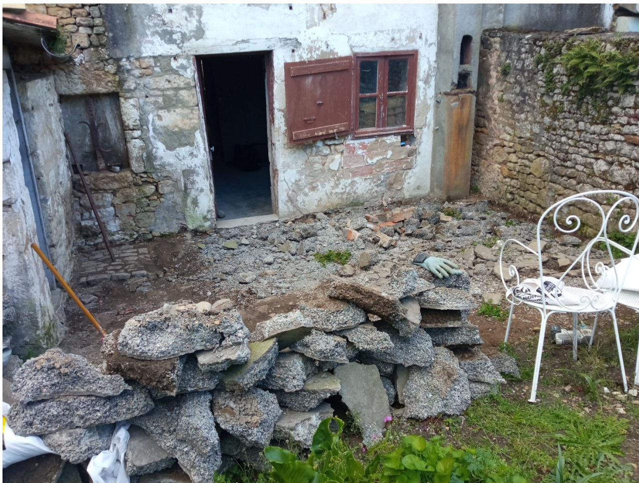
La terrasse en phase destruction (mars-avril 2026)
