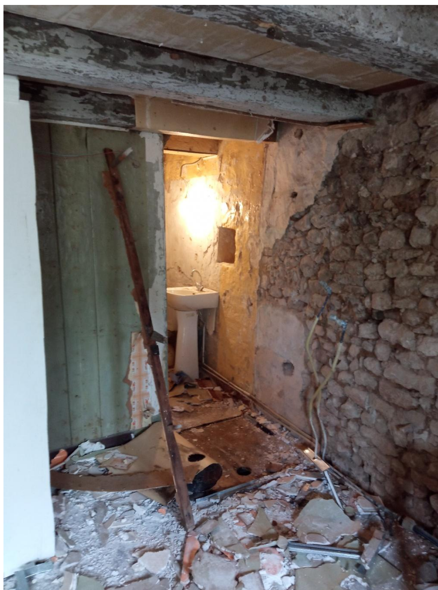
Ancienne salle d'eau
