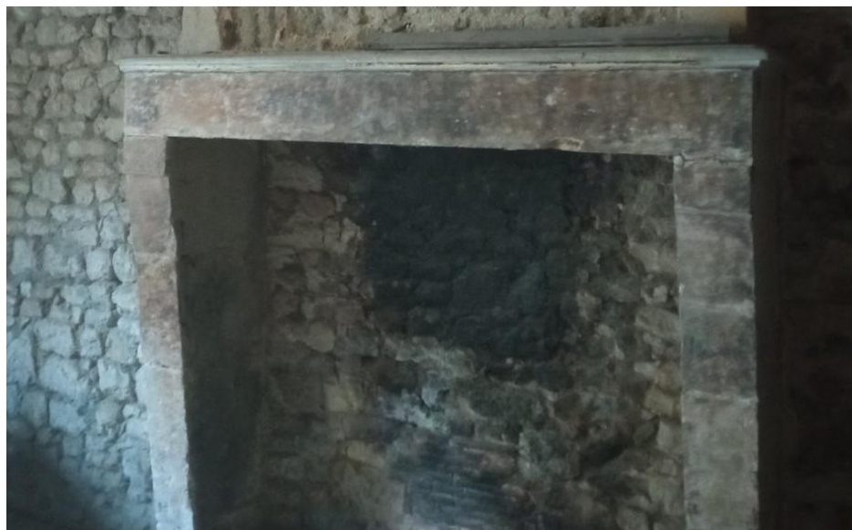
cheminée rez-de-chaussée sur rue
