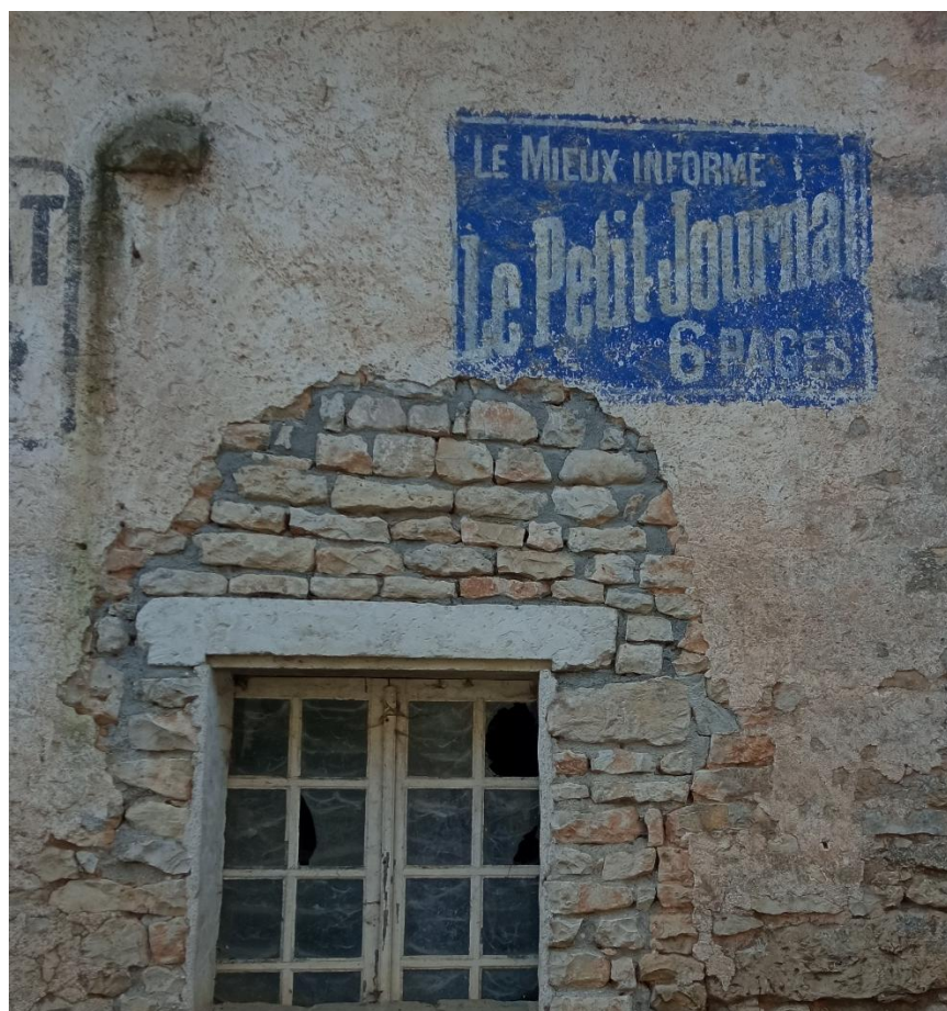
Façade de rue
