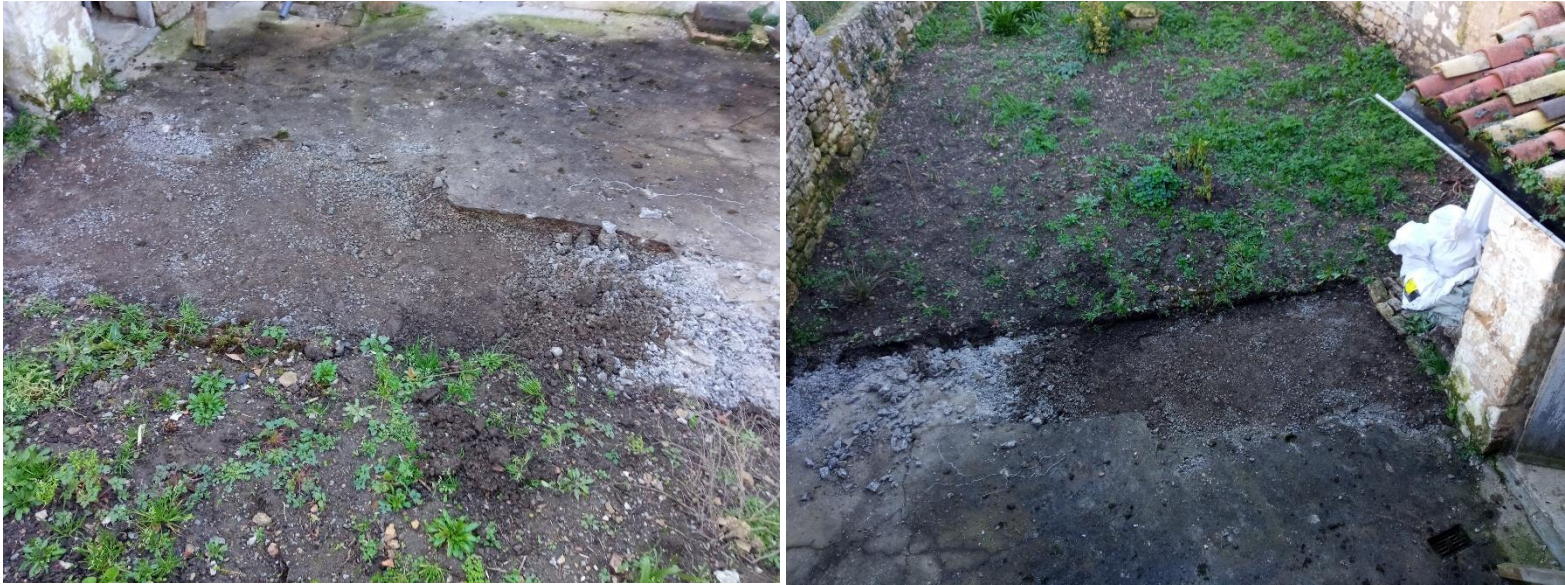
Travaux dans la cour
