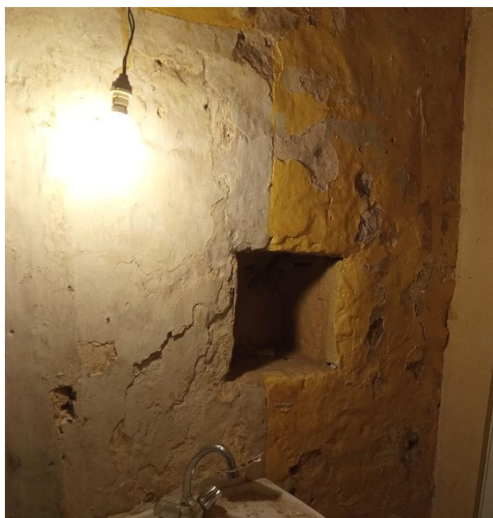
niche dans la salle d'eau
