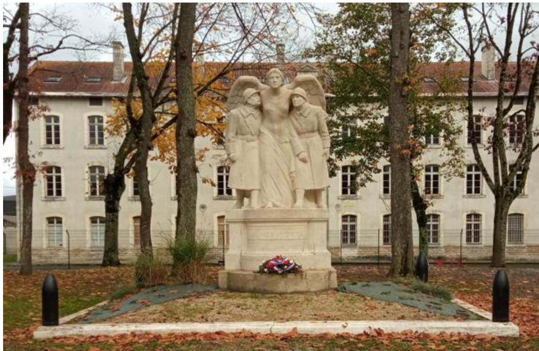
Rénovation du Monument du souvenir (Caserne Marchand – Saint-Maixent-l'École)
