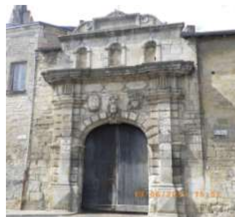
Porte Canclaux, édifée en 1660
