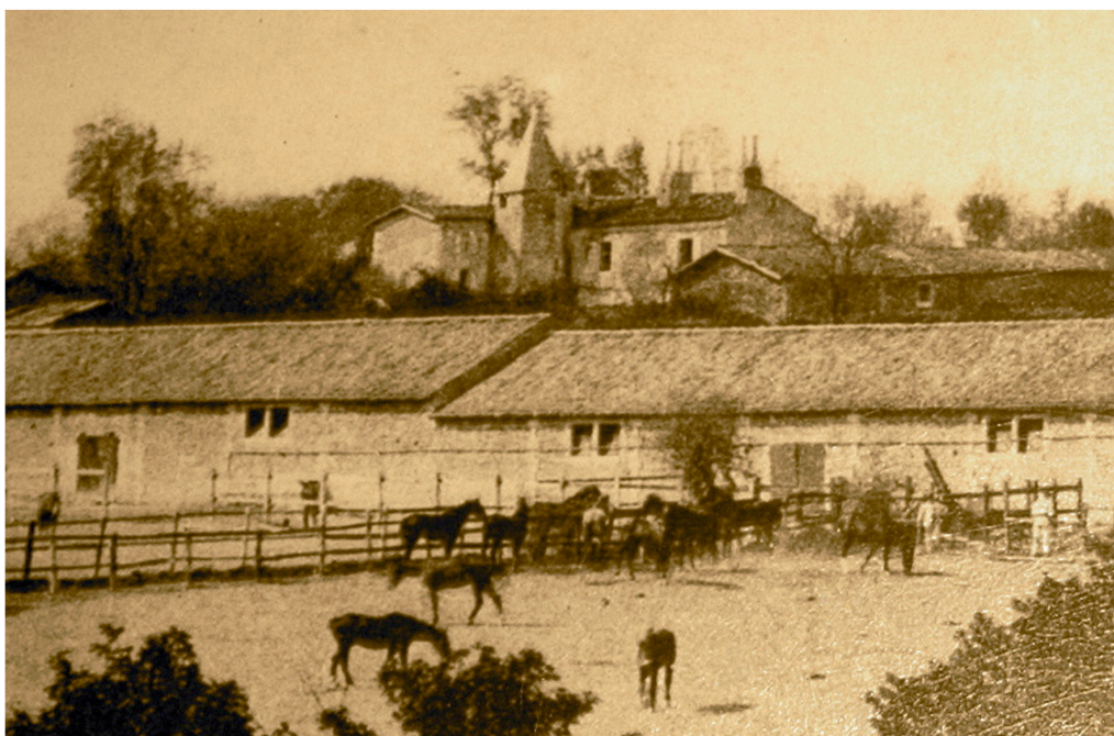
La station de remonte et le château en arrière-plan
